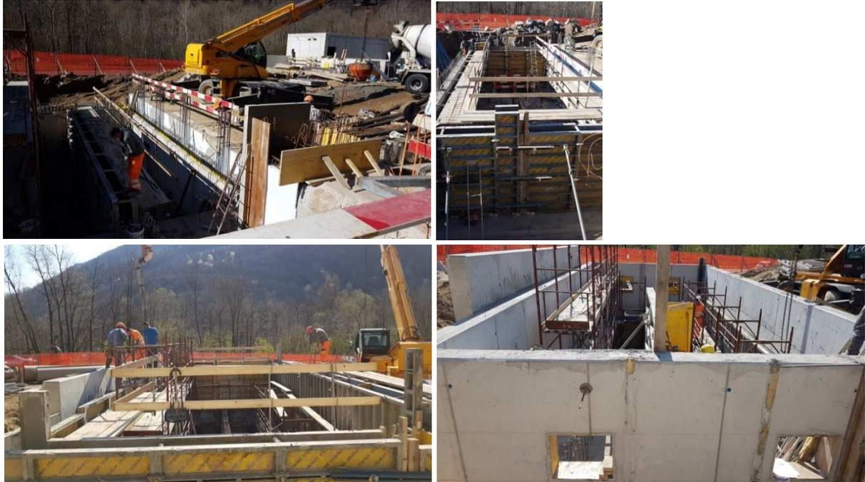
Eseguito lo scavo, la posa del ferro e getto per la platea del canale di sfioro situato a fianco della vasca di decantazione primaria.
